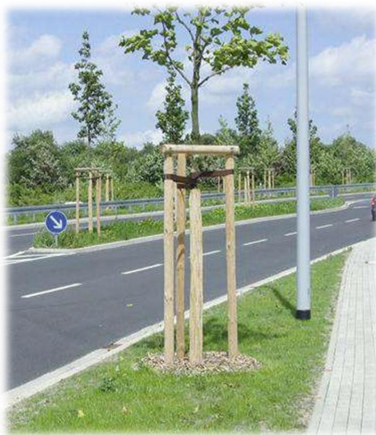
FOT. 1 PRZYKŁAD WZORCOWEGO OPALIKOWANIA 3 PALIKAMI, STABILIZACJA TAŚMĄ ELASTYCZNĄ
